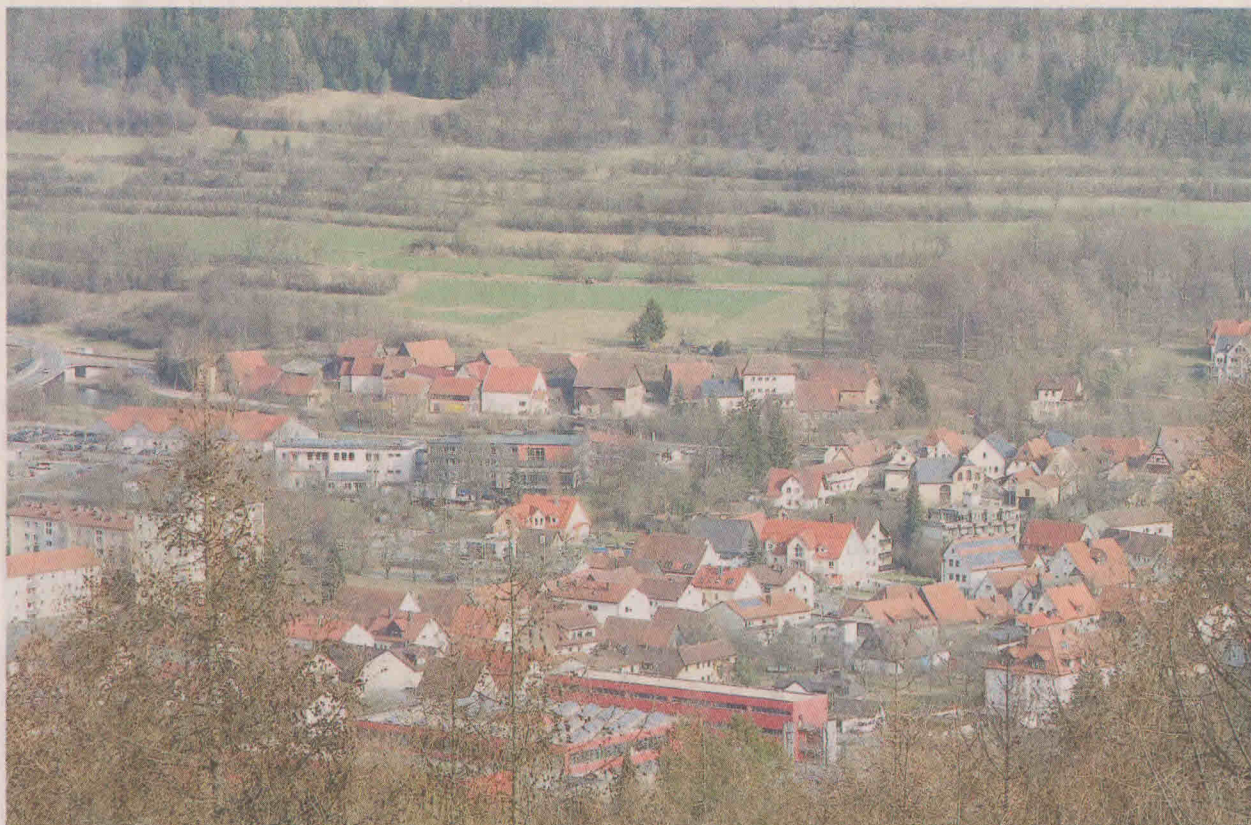
Zwischen Ramstertalstraße (oben li.), Scheunenviertel und dem Stadtpark (oben re.) liegt das neue Baugebiet. Fotos: Och
